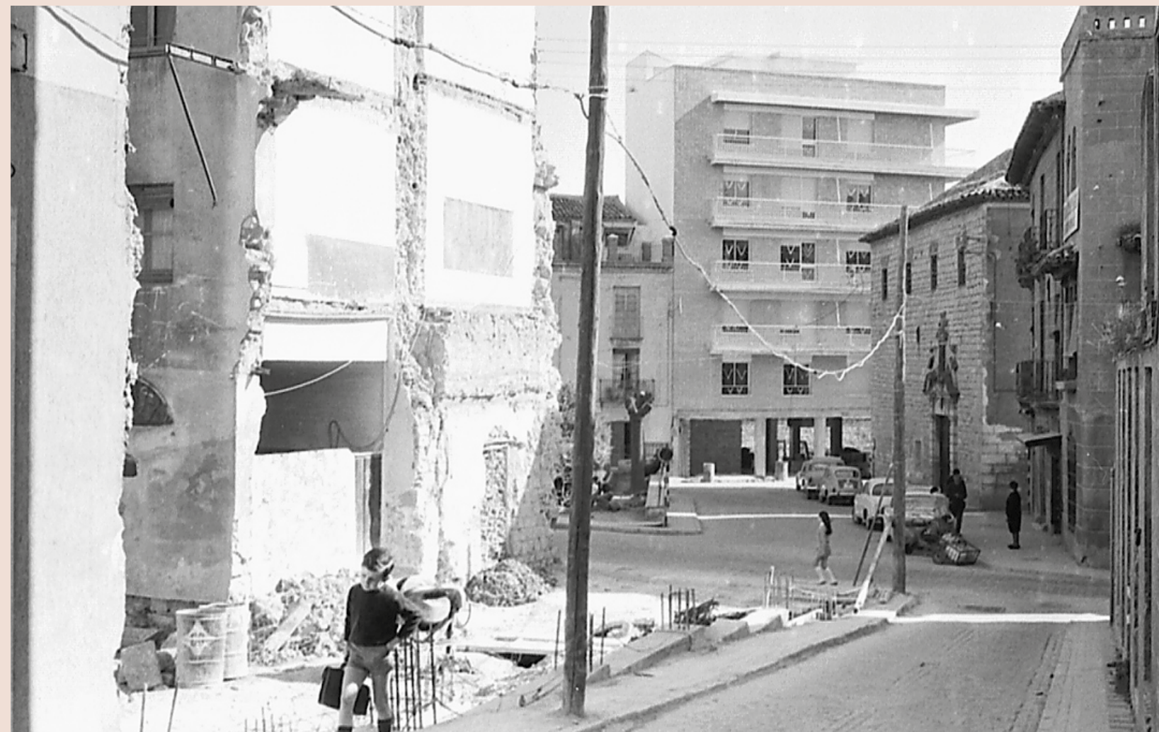
Esquina en construcción en la calle Ruiz Romero
