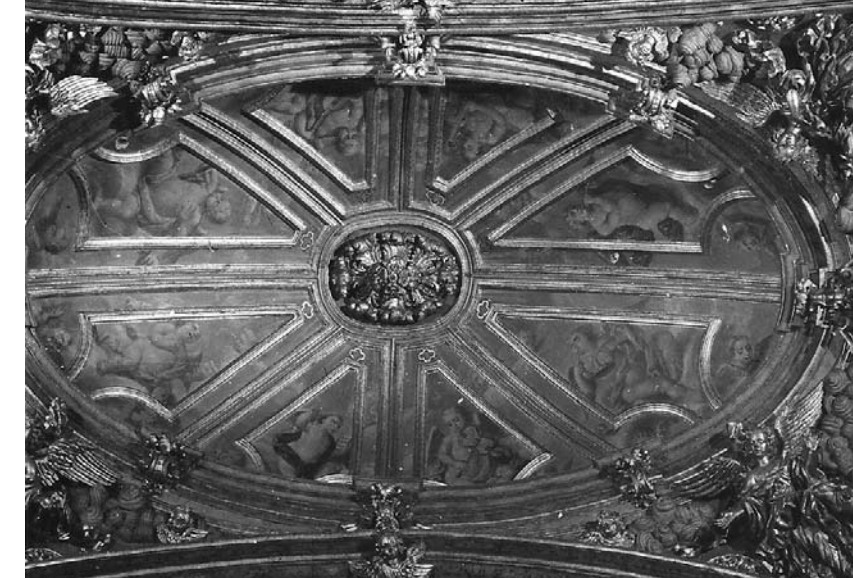
Bóveda del presbiterio. (Iglesia de San Ildefonso. Jaén)
